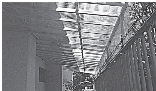
(工事中、ビニール屋根の出入り口)
