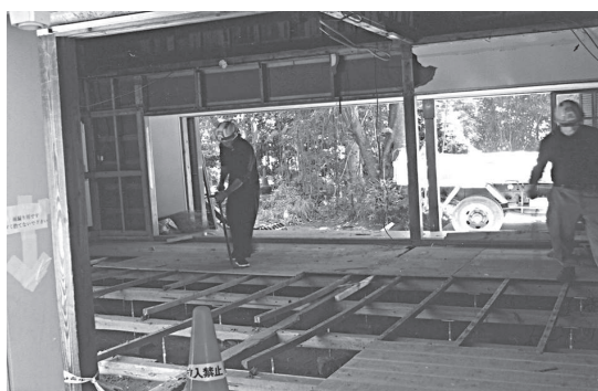
(控室撤去作業)
